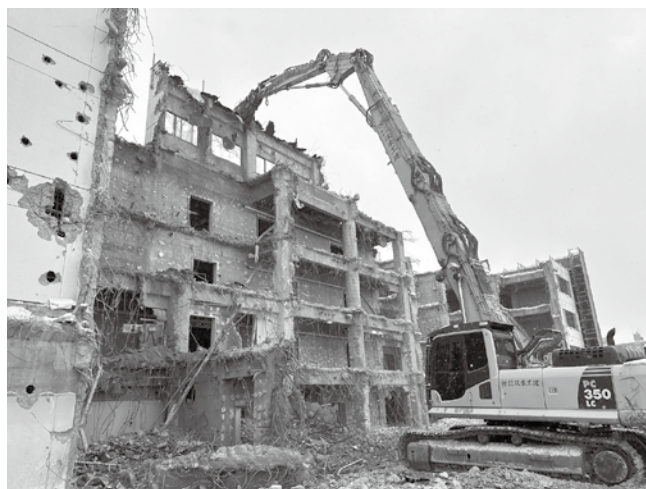
商業施設やマンションなど、大規模な現場の解体工事を担う
